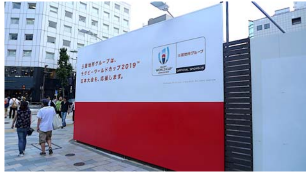
協賛イベントのPRも兼ねる工事仮囲い
