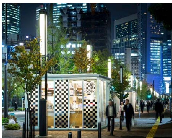
街灯と調和した道路内建築の照明
